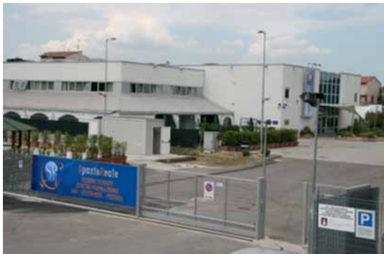
CENTRO SPAZIO REALE - PARZIALE VISIONE ESTERNA
